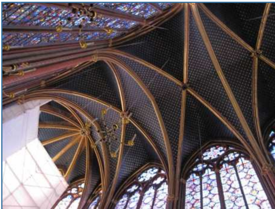
La bóveda estrellada corona una estructura que sustituyó los muros por cristal: gótico radiante en estado puro.
