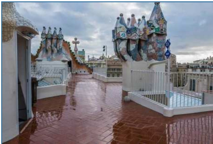
Las chimeneas de trencadís y el tejado escamado de la azotea.
