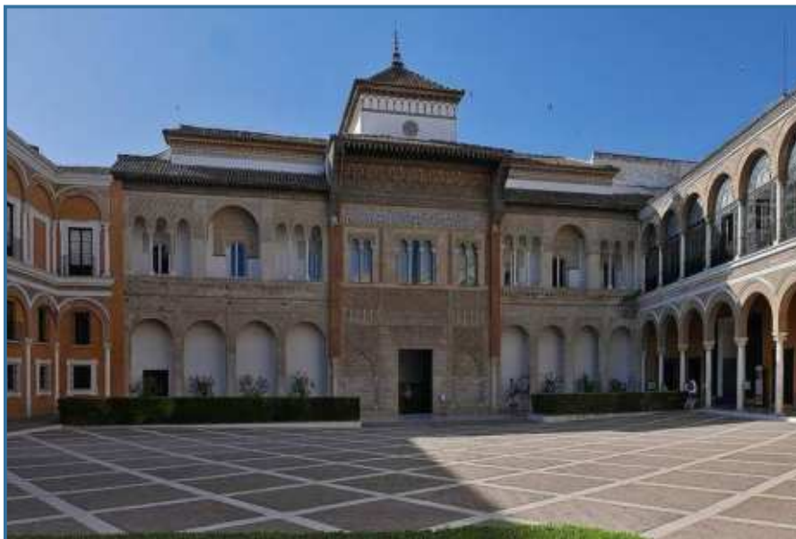
La fachada mudéjar del Palacio de Pedro I desde el Patio de la Montería.
